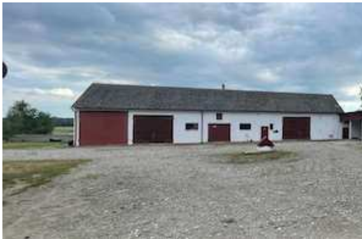
Widok budynku gospodarczego
