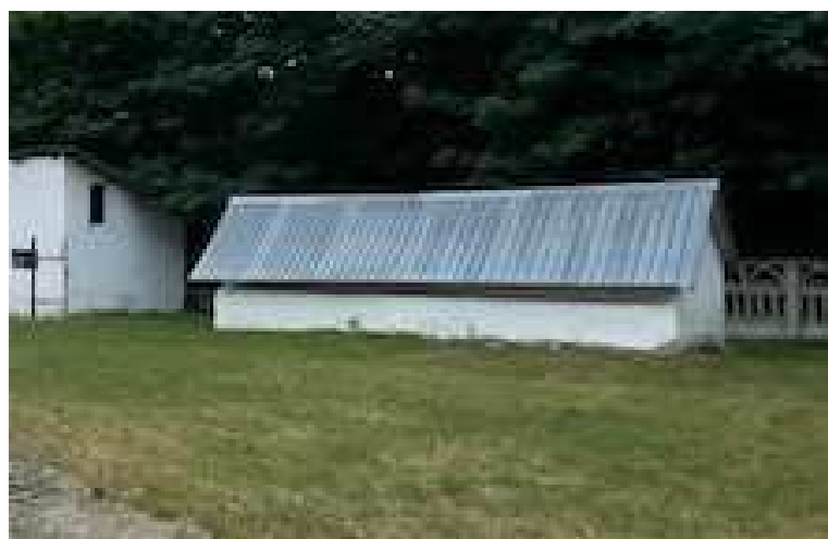
Widok budynku gospodarczego
