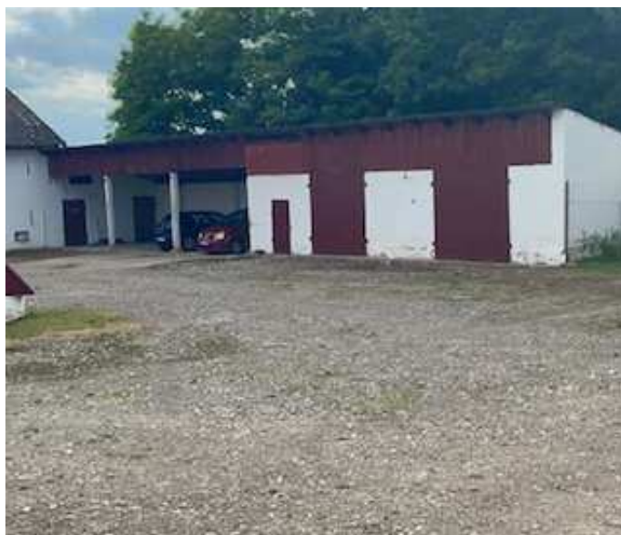
Widok budynku gospodarczego
