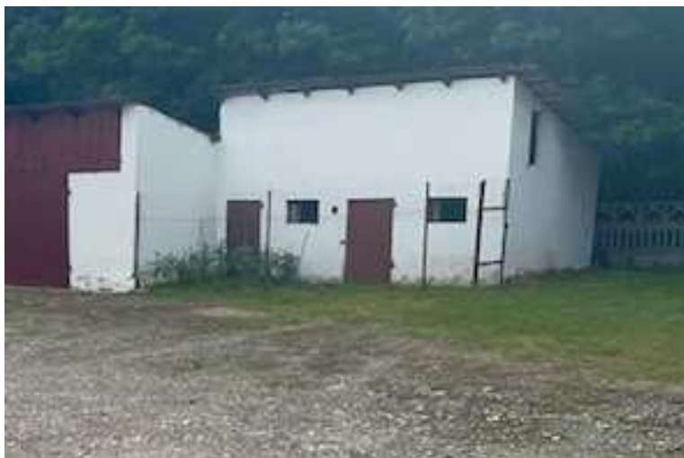
Widok budynku gospodarczego
