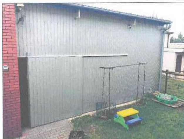
Fot.20. Widok budynku gospodarczo-garażowego
