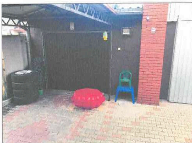
Fot.19. Widok budynku gospodarczo-garażowego
