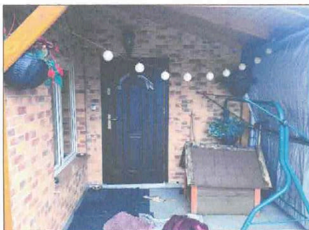
Fot.5. Widok drzwi wejściowych na klatce schodowej
